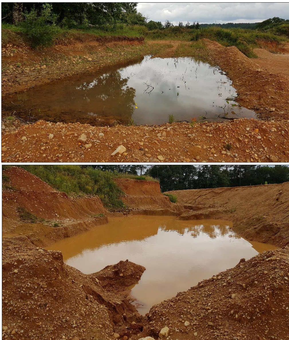
Figure 10 : Illustrations photographiques des bassins de rétentions observés sur site, le 24/06/2021
