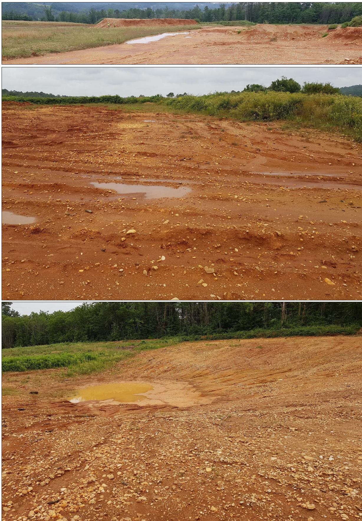
Figure 7 : Illustrations photographiques de zones de stagnation des eaux observées sur site, le 24/06/2021
