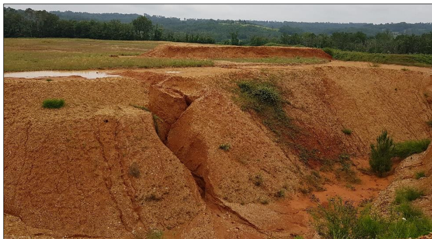
Figure 9 : Illustration photographique de l’excavation servant comme exutoire d’une partie des ruissellements du site, observée le 24/06/2021
